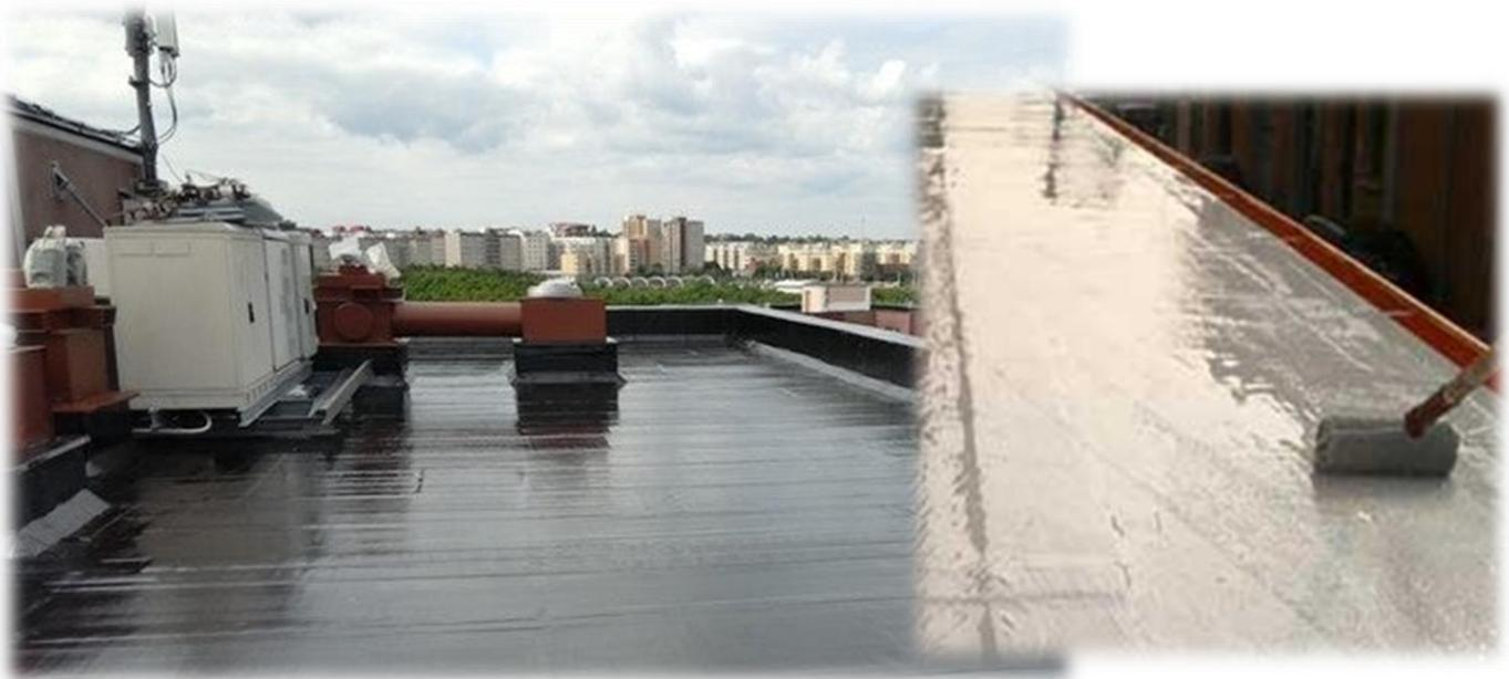
En la primera foto puede verse una impermeabilización con **FIBRASEAL** reforzada en proceso de curado y en la otra foto como queda con dos capas finales de **WHITE REFLEX** de **ASSA**.
